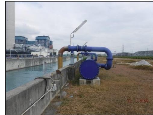
รูปที่ 2-29 ระบบเติมอากาศ FGD Chamber บริเวณคลองระบายน้ำหล่อเย็นทั้ง 2 หน่วยผลิต
