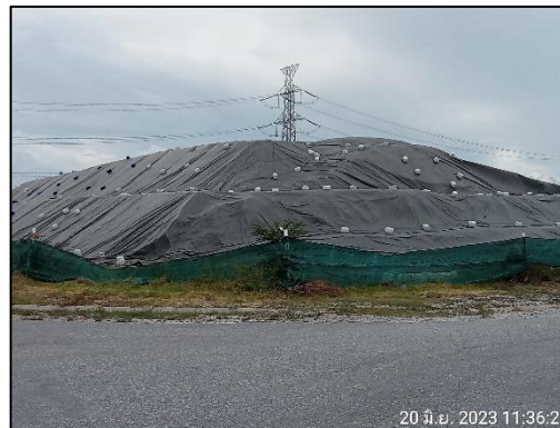
รูปที่ 2-11 การปิดปกคลุมกองเถ้าถ่านหินด้วยผ้าใบ เพื่อป้องกันการแพร่กระจายของฝุ่นละออง
