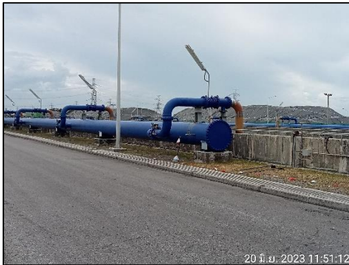
รูปที่ 2-29 ระบบเติมอากาศ FGD Chamber บริเวณคลองระบายน้ำหล่อเย็นทั้ง 2 หน่วยผลิต
