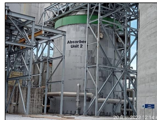
รูปที่ 2-7 ระบบดักจับก๊าซซัลเฟอร์ไดออกไซด์ (Sea Water FGD)
