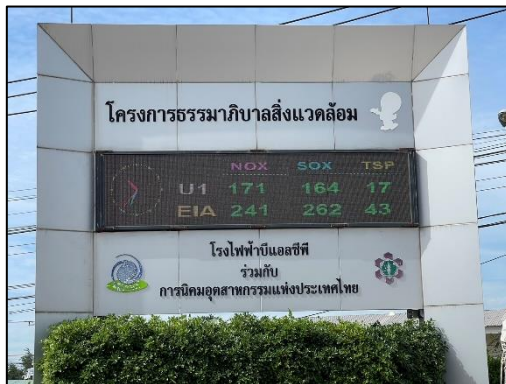
รูปที่ 2-9 การนำเสนอข้อมูลการตรวจวัดคุณภาพอากาศผ่านระบบออนไลน์
