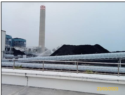
รูปที่ 2-4 การฉีดสเปรย์น้ำบริเวณลานกองถ่านหินของโครงการ
