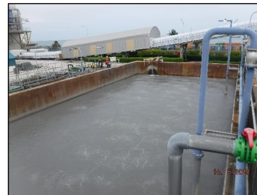
รูปที่ 2-23 ระบบบำบัดน้ำเสียสำหรับรองรับน้ำเสียจากกระบวนการผลิตกระแสไฟฟ้า
