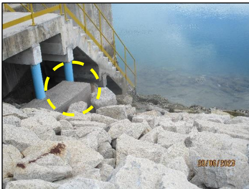
รูปที่ 2-36 ทางออกสำหรับสัตว์น้ำที่หลบออกจากระบบสูบน้ำหล่อเย็น
