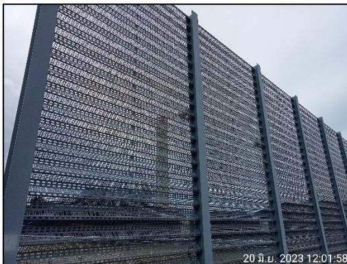
รูปที่ 2-2 กำแพงเบี่ยงเบนทิศทางลมสูง 6 เมตร บริเวณด้านทิศใต้ของลานกองถ่านหิน
