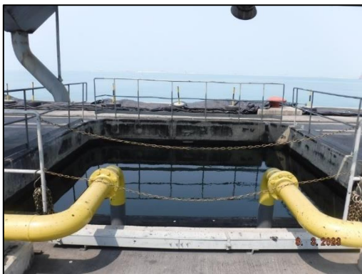
รูปที่ 2-26 บ่อรวบรวมน้ำจากกิจกรรมของท่าเรือขนถ่ายถ่านหินของโครงการฯ
