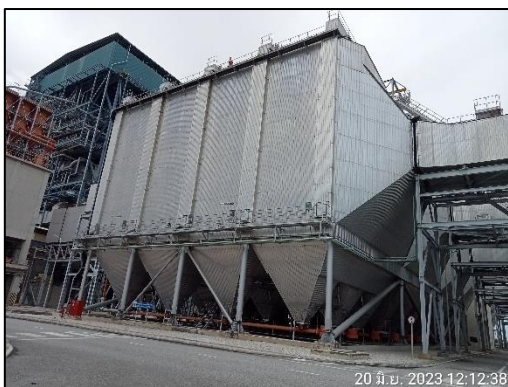
รูปที่ 2-6 ระบบดักจับฝุ่นละอองโดยใช้ไฟฟ้าสถิตย์ (EP)
