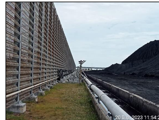
รูปที่ 2-3 หัวฉีดสเปรย์น้ำบริเวณลานกองถ่านหินของโครงการฯ
