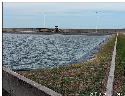
รูปที่ 2-28 บ่อรวบรวมน้ำจากบริเวณพื้นที่ลานกองถ่านหินที่ปูพื้นด้วยแผ่นพลาสติกชนิด HDPE
