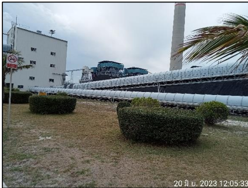
รูปที่ 2-1 สายพานลำเลียงระบบปิดบริเวณลานกองถ่านหินของโครงการฯ
