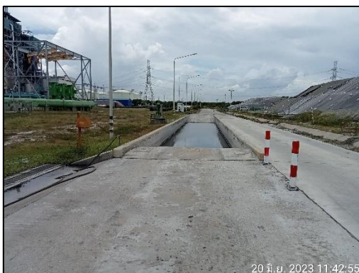
รูปที่ 2-14 บ่อล้างล้อรถบรรทุกบริเวณลานกองเก็บถ่านหินชั่วคราว
