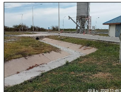
รูปที่ 2-15 รางระบายน้ำล้อมรอบบริเวณกองพักถ่านหินชั่วคราวของโครงการฯ
