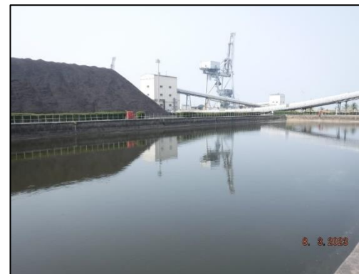
รูปที่ 2-27 บ่อดักตะกอนบริเวณลานกองถ่านหินของโครงการฯ
